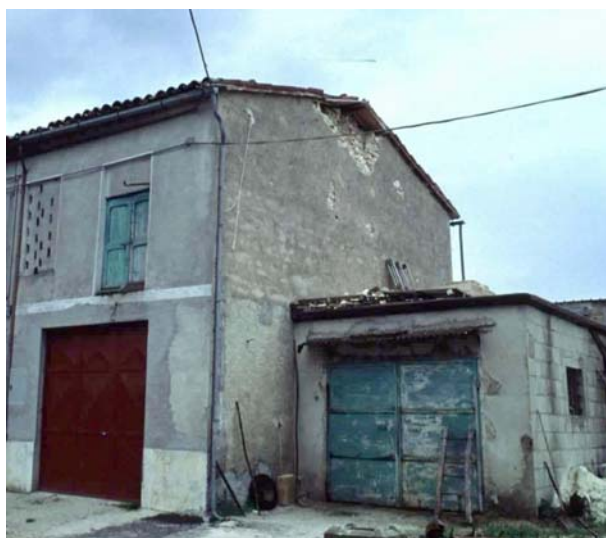
Fig. 4.11 – Meccanismo di sfondamento della parete del timpano (Foto da: MEDEA - Zuccaro, Papa - 2003, DPC)
