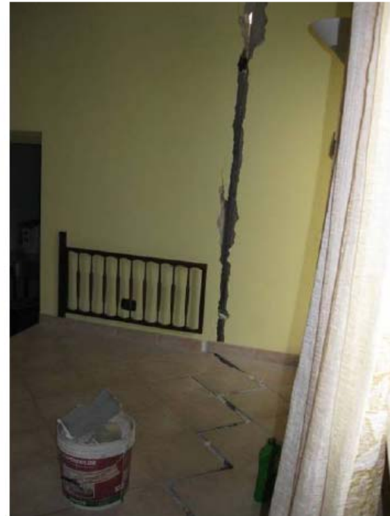
Fig. I.8 Paganica: Danni ai tubi dell'acquedotto del Gran Sasso e lesioni in un'abitazione posta in prossimità (42°21'52.42''N 13°28'07.68''E)
