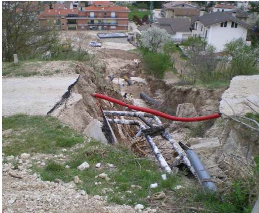
Fig. I.8 Paganica: Danni ai tubi dell'acquedotto del Gran Sasso e lesioni in un'abitazione posta in prossimità (42°21'52.42''N 13°28'07.68''E)
